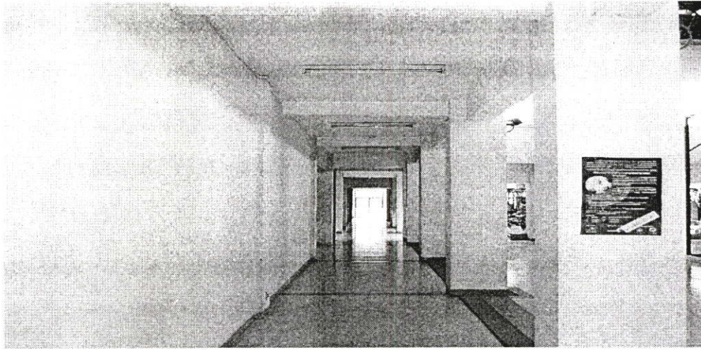
รูปที่ 4.3 ภาพถ่ายภายในอาคารเรียนคอนกรีต
