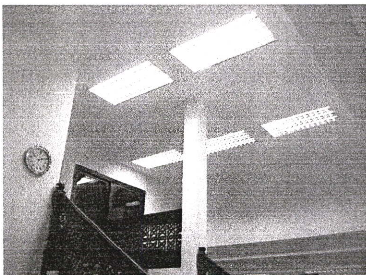
ภาพที่ 4.12 แสดงแสงสว่างภายในอาคาร
