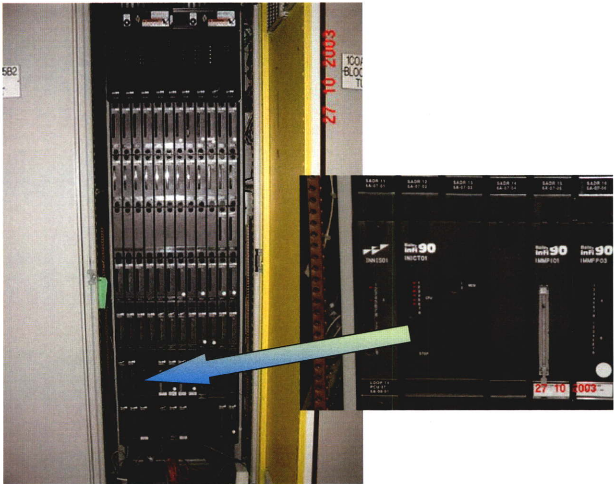
รูปที่ 5.7 แสดง Computer Interface Card INICT01 ของโรงไฟฟ้าพลังความร้อนร่วม
