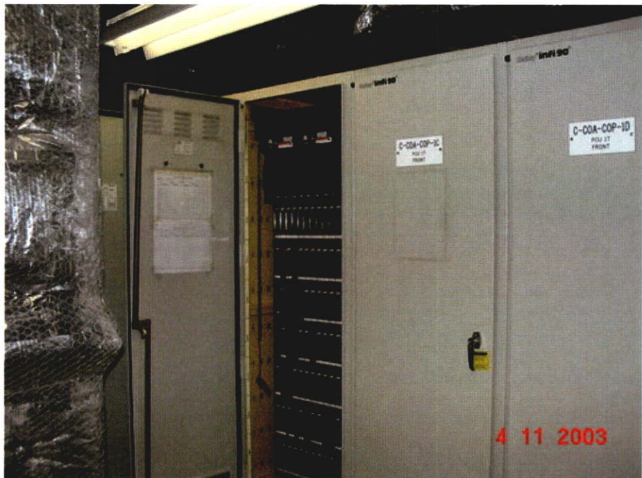
รูปที่ 5.2 แสดงตู้ DCIS สำหรับต่อ Interface computer
