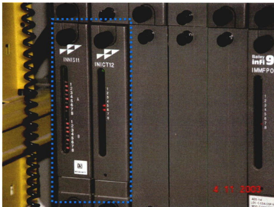
รูปที่ 5.3 แสดงการ์ด Computer Interface Unit INICT12
