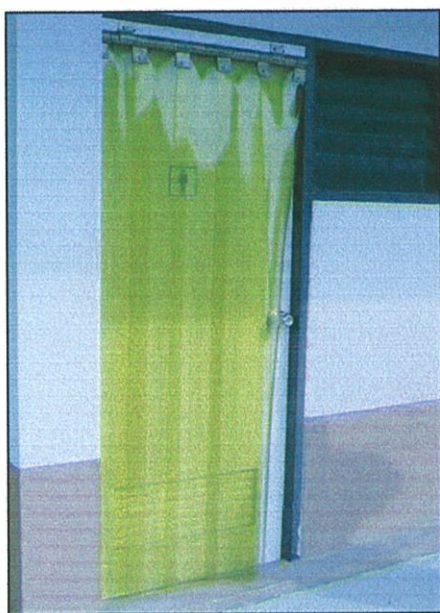
ภาพที่ 4.4 แสดงประตูทางเข้าอาคารผลิตซึ่งมีการป้องกันการปนเปื้อนจากภายนอก
