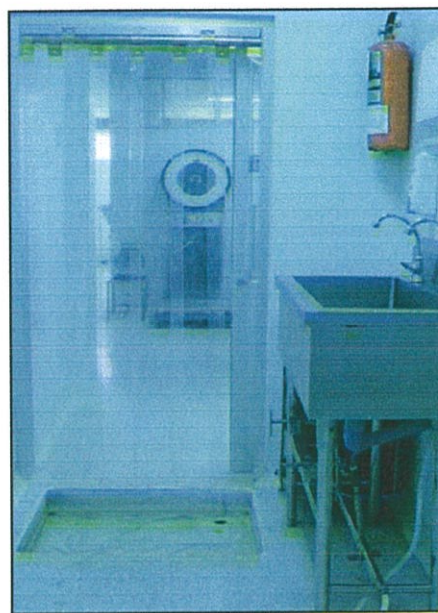
ภาพที่ 4.4 แสดงประตูทางเข้าอาคารผลิตซึ่งมีการป้องกันการปนเปื้อนจากภายนอก
