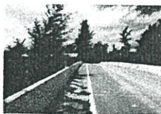
สะพานคอนกรีตที่ก่อนเข้าโครงการ
