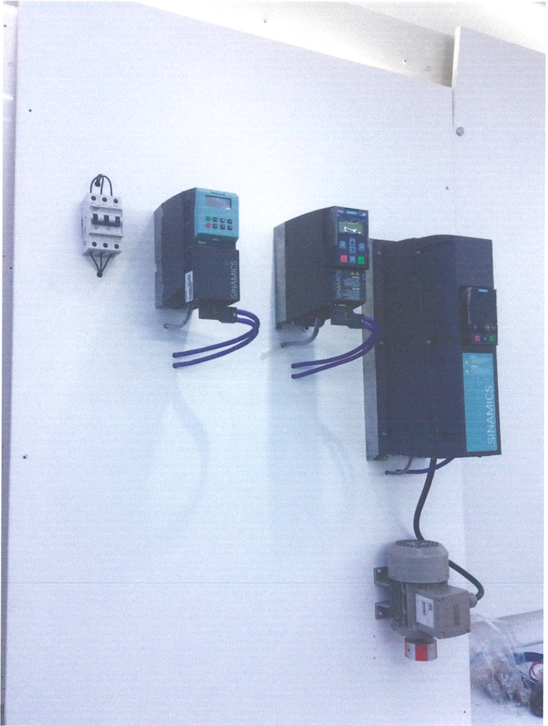
รูปที่ 4.16 การติดตั้งอุปกรณ์แผงสาธิตที่ 4 (ฝั่งประตู)
