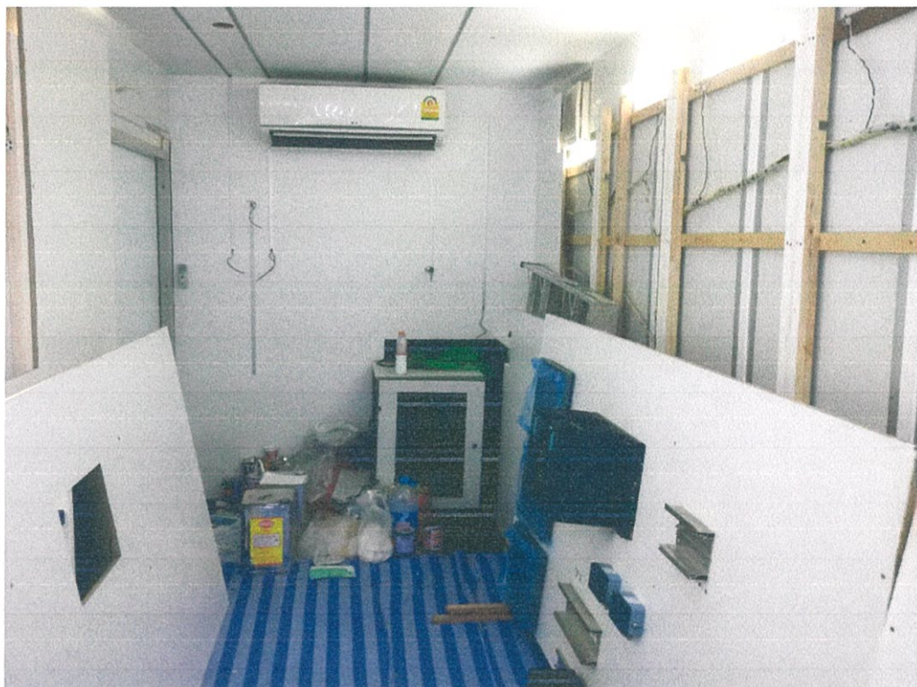
รูปที่ 3.25 การติดตามการดำเนินการเปลี่ยนแผงสาธิต
