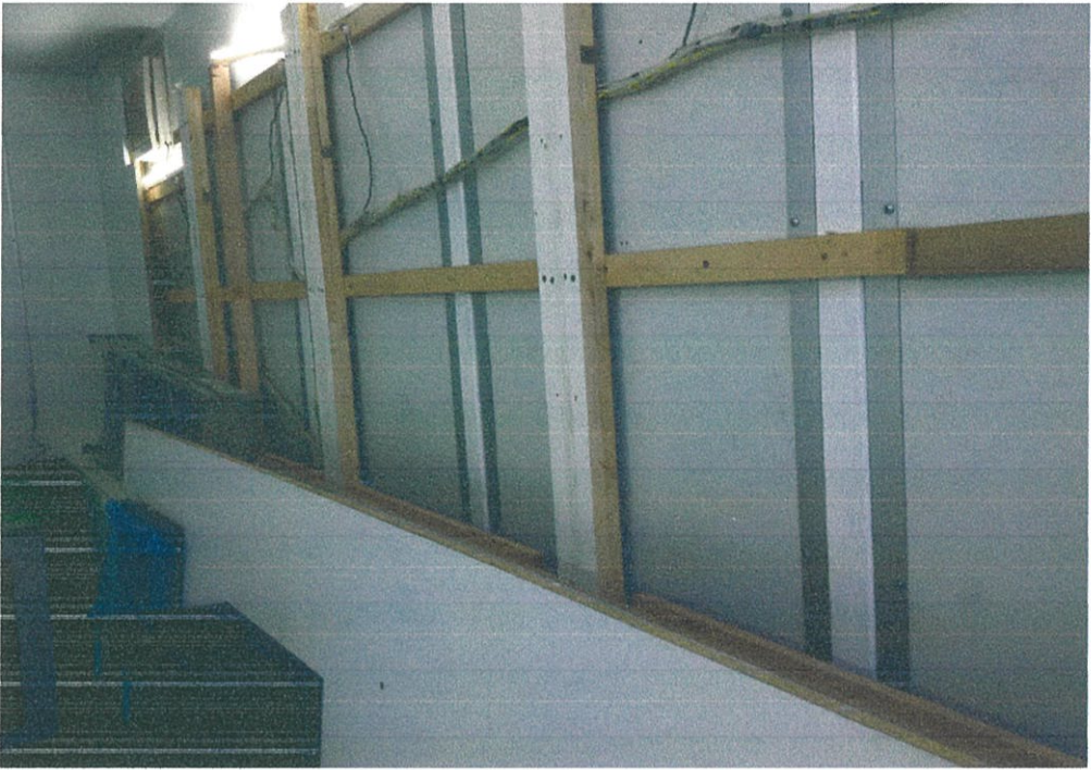
รูปที่ 3.26 การติดตามการดำเนินการเปลี่ยนแผงสาธิต
