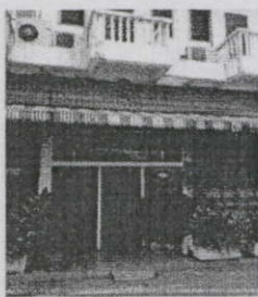
ภาพที่ 1.1 คริสตจักรเจริญธรรมที่1 เชียงใหม่ เป็นคริสตจักรขนาดเล็กที่ดัดแปลงจากอาคารพาณิชย์ ขนาด1คูหา
