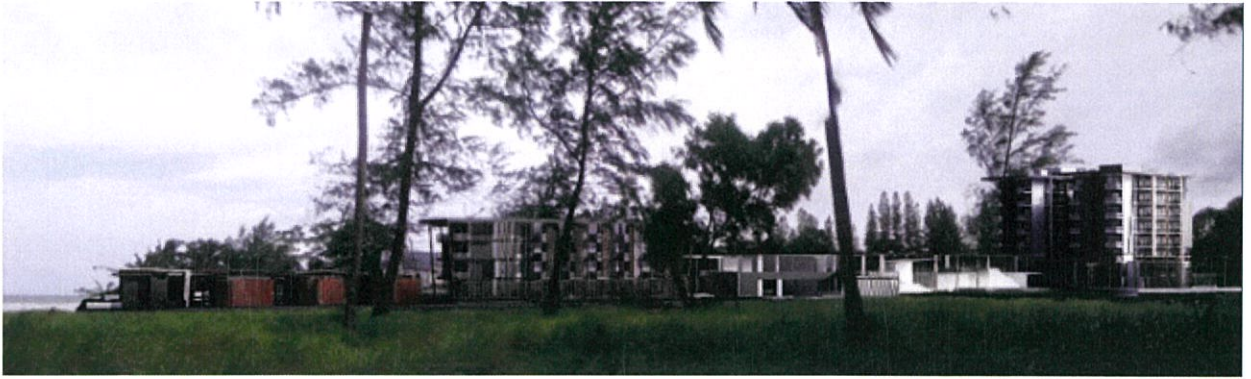
รูปที่ 13 รูปด้านอาคารทั้งหมดของโครงการ
