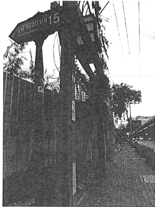
รูปภาพ 3.39 แสดงมุมมองอาคารทางทิศใต้จากปากซอยจุฬาร 5
