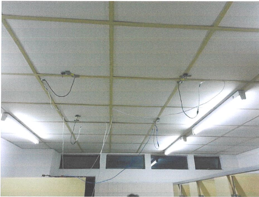
รูปที่ 4.19 การติดตั้งอุปกรณ์
