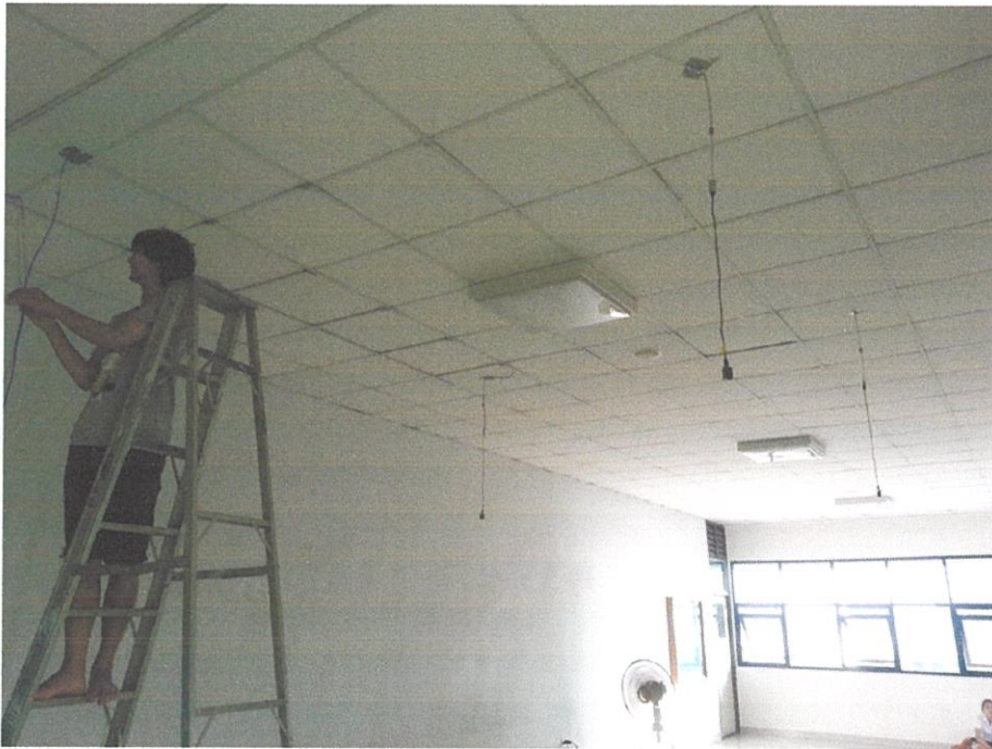
รูปที่ 4.27 ติดตั้งอุปกรณ์
