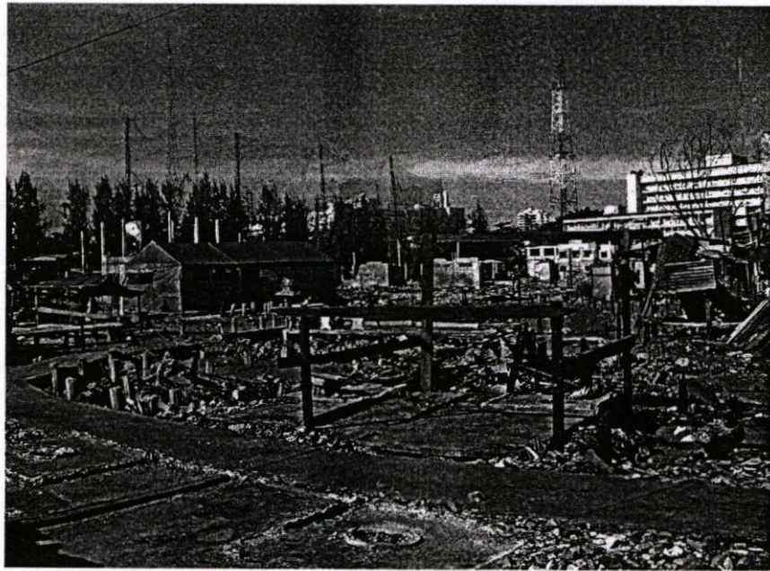
ภาพที่ 4.2 ภาพถ่ายชุมชนหมู่บ้านพัฒนาซอยสวนพลูที่ถูกเพลิงไหม้ (ถ่ายเมื่อวันที่ 25 เมษายน 2547)
