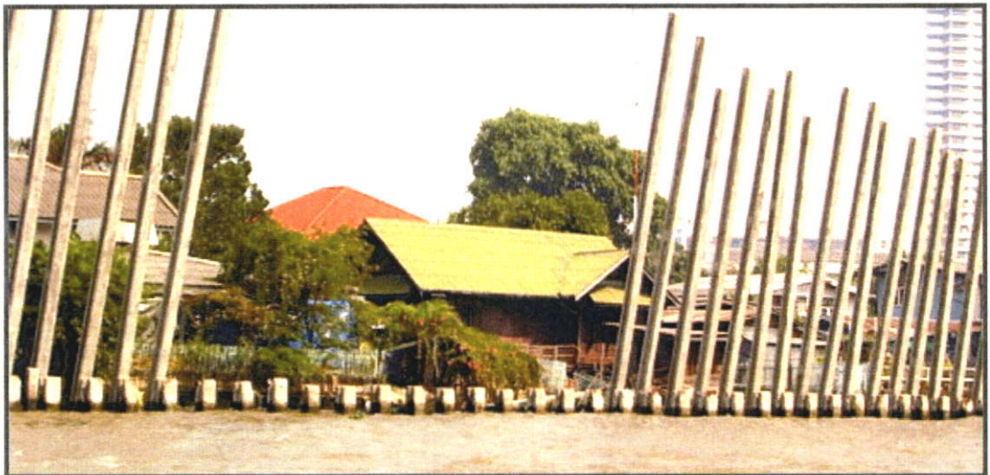
รูปที่ 4.1.3-5 ลักษณะตลิ่งทางฝั่งเหนือของคลองบางกอกน้อยอยู่ในช่วงดำเนินการสร้างเขื่อน
