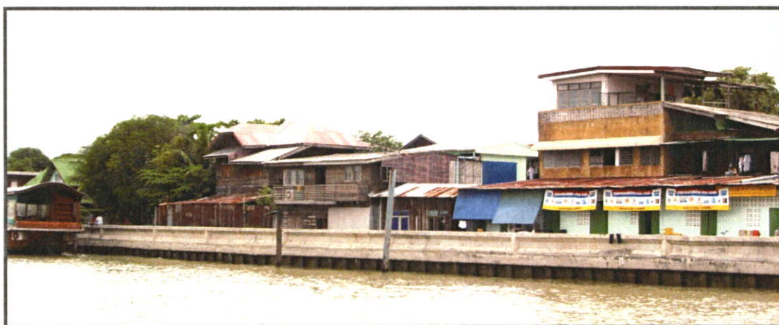
รูปที่ 4.1.3-3 ลักษณะตลิ่งคอนกรีตที่สร้างขึ้นเองโดยกรมการขนส่งทางน้ำและพาณิชยนาวี (กรมเจ้าท่าเดิม) บริเวณริมคลองบางกอกน้อย
