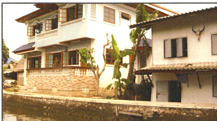
รูปที่ 4.1.3-1 ลักษณะตลิ่งคอนกรีตที่สร้างขึ้นเองโดยเอกชน
