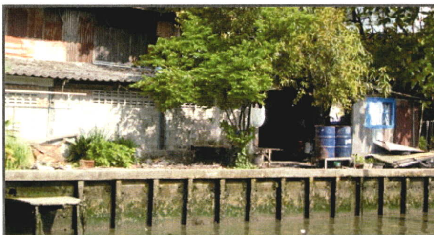
รูปที่ 4.1.3-2 ลักษณะตลิ่งคอนกรีตที่สร้างขึ้นเองโดยกรมการขนส่งทางน้ำและพาณิชยนาวี (กรมเจ้าท่าเดิม) บริเวณริมคลองด่าน
