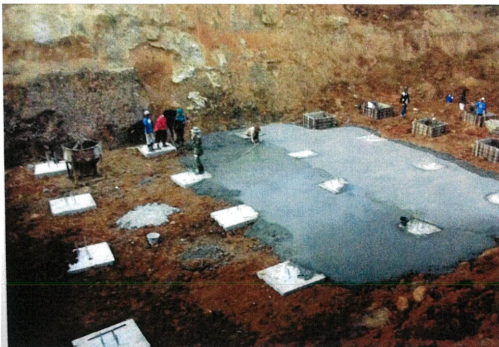
รูปที่ 5.11 แสดงการเทคอนกรีตหยาบ
