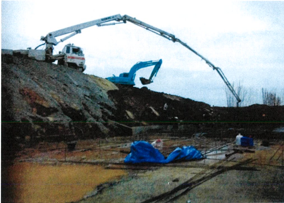
รูปที่ 5.15 แสดงการเทคอนกรีตโดยใช้คอนกรีตปั๊ม
