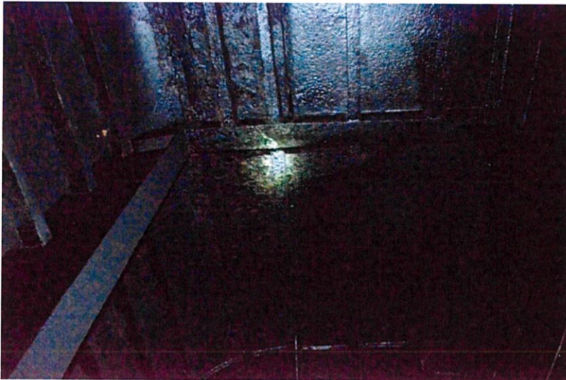
รูปที่ ก-2 เหล็กฉากรูปตัว L ที่เชื่อมต่อกับผนังและคาน
