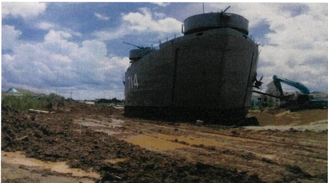
รูปที่ 6.5 แสดงการวางตำแหน่งของเรือเมื่อสูบน้ำออกจากบ่อหมด
