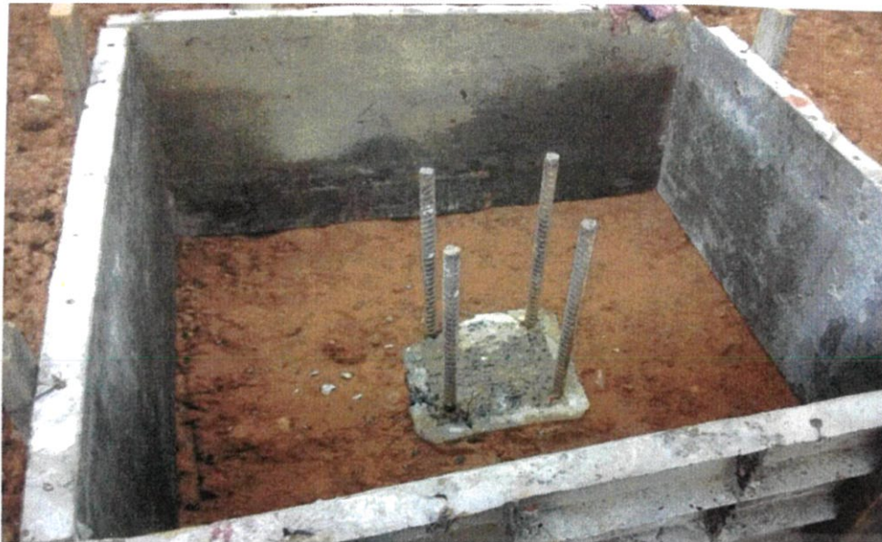
รูปที่ 5.9 แสดงการเข้าแบบ Drop Panel
