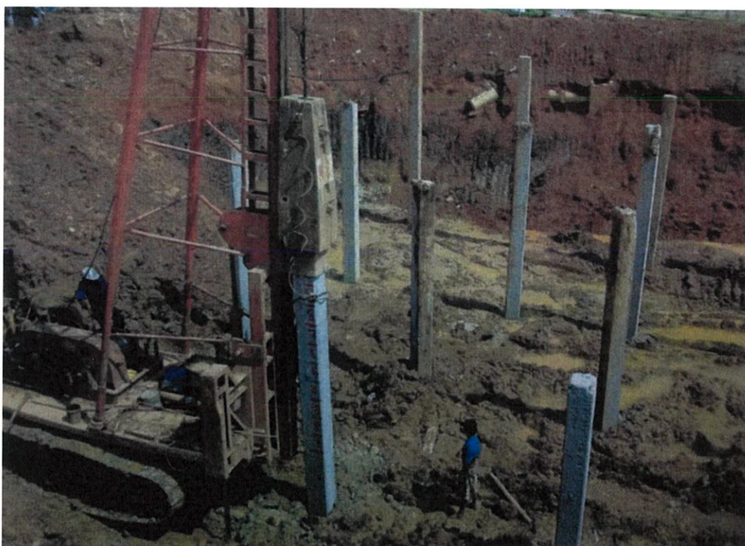
รูปที่ 4.7 แสดงการตอกเข็มด้วยปั่นจั่น
