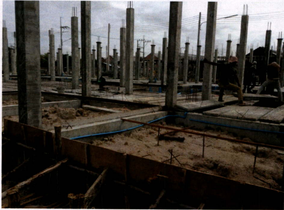
งานติดตั้งแผ่นพื้นสำเร็จรูปชั้น 1 วันที่ 10 กันยายน 2556
