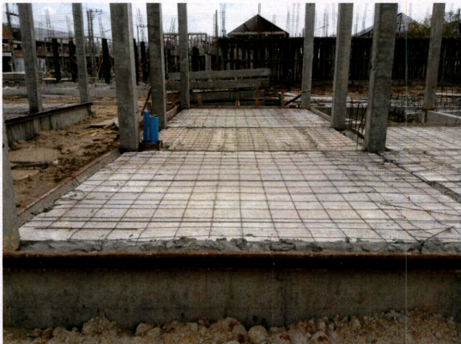
รูปที่ 4.5 การวางเหล็กกันรั่วก่อนเทคอนกรีตทับพื้นแผ่นพื้นสำเร็จรูป ชั้น 1
