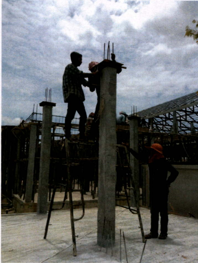
รูปที่ 4.24 การติดตั้งฉากรัดหัวเสา เพื่อรองรับชั้นส่วนคานสำเร็จรูปในชั้น 2
