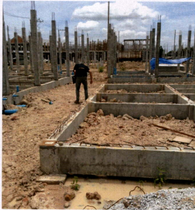
เสร็จสิ้นงานคานชั้น 1 วันที่ 16 สิงหาคม 2556
