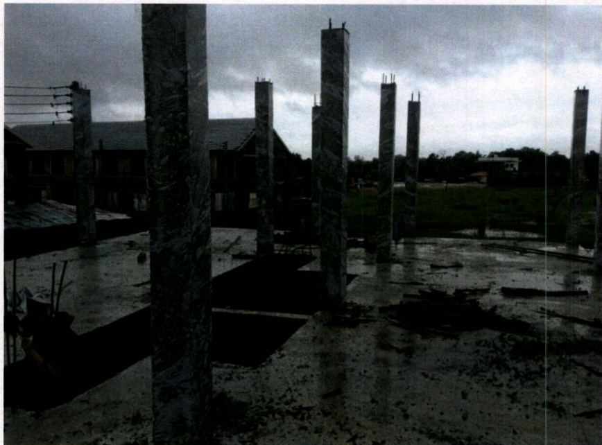
รูปที่ 4.11 การบ่มคอนกรีตเสาชั้น 2 โดยการฉีบน้ำที่เสาคอนกรีตแล้วหุ้มด้วยพลาสติก
