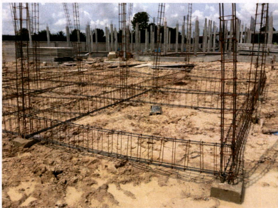
รูปที่ 4.1 การวางเหล็กเสริมในคานชั้น 1
