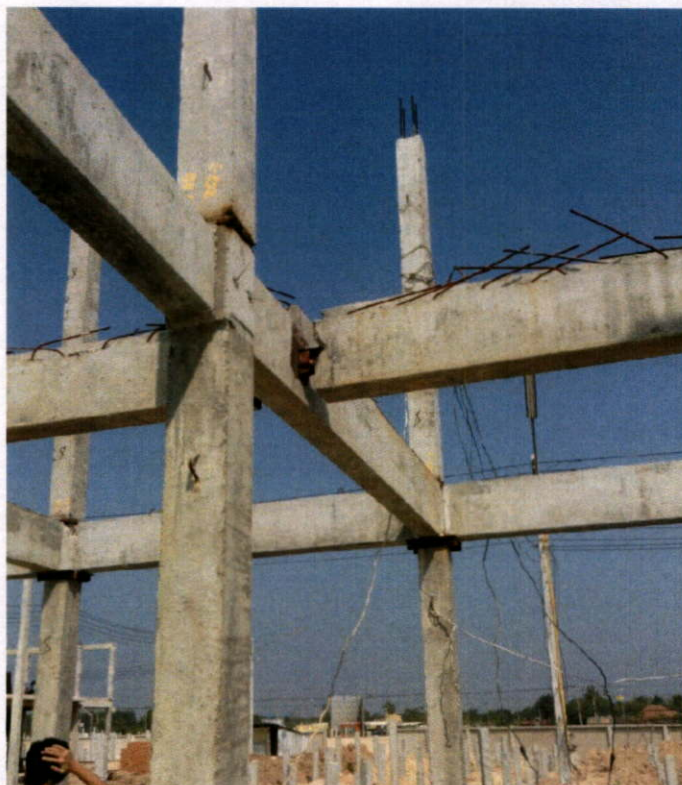
รูปที่ 4.31 จุดรอยต่อ เสา-คาน ชั้น 2
