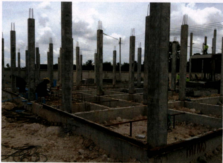
งานทาสีกันสนิมเพลาทหัวเสา และทำค้ำยันท้องพื้นชั้น 1 วันที่ 5 กันยายน 2556
