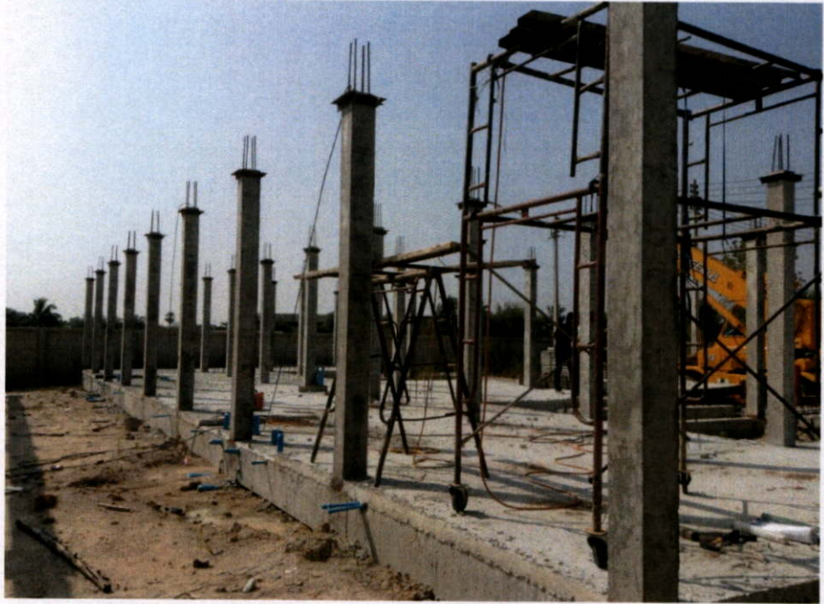
งานติดตั้งฉากรัดหัวเสา วันที่ 17 กันยายน 2556
