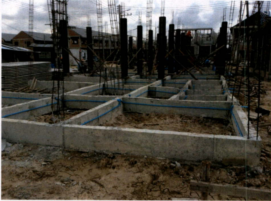
รูปที่ 4.3 การประกอบไม้แบบ และการค้ำยันเสาชั้น 1
