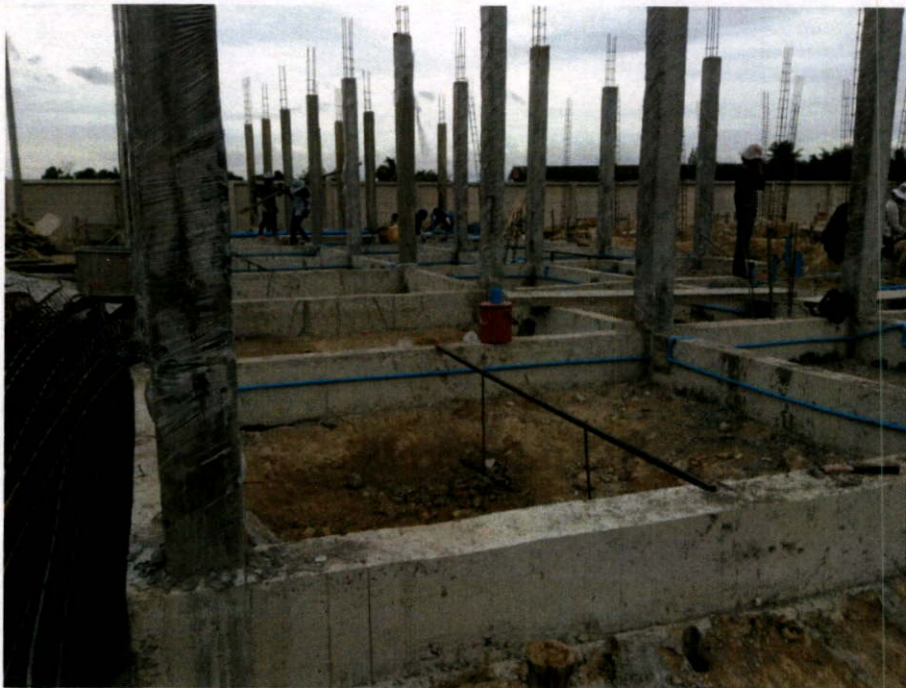
รูปที่ 4.4 การบ่มคอนกรีตเสาชั้น1 โดยการฉีบน้ำที่เสาคอนกรีตแล้วหุ้มด้วยพลาสติก
