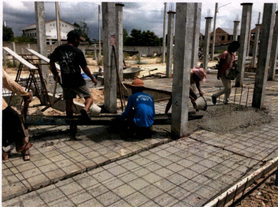
งานติดตั้งแผ่นพื้นสำเร็จรูปชั้น 1 วันที่ 10 กันยายน 2556
