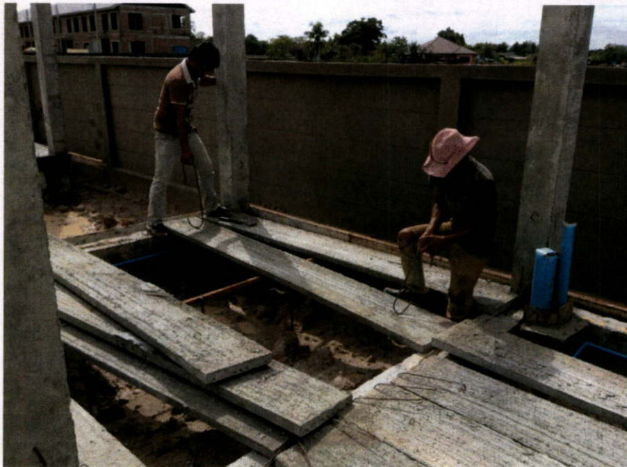
งานวางพื้นชั้น วันที่ 5 กันยายน 2556
