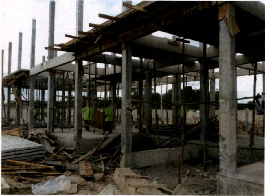
งานประกอบติดตั้งแผ่นพื้นสำเร็จรูปชั้น 2 วันที่ 25 ตุลาคม 2556
