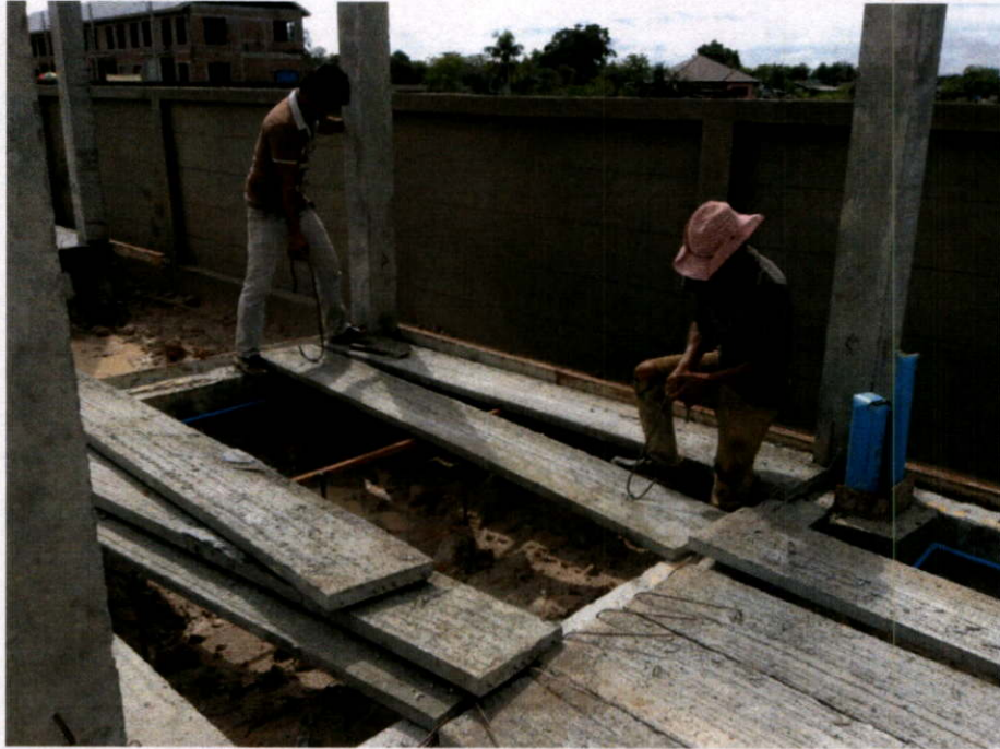
รูปที่ 4.21 การจัดเรียงแผ่นพื้นสำเร็จรูป
