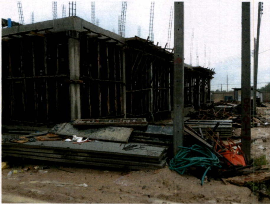
รูปที่ 4.9 การถอดแบบข้างคานชั้น 2 บางส่วน และการกองเก็บไม้แบบ ไม้ค้ำยัน
