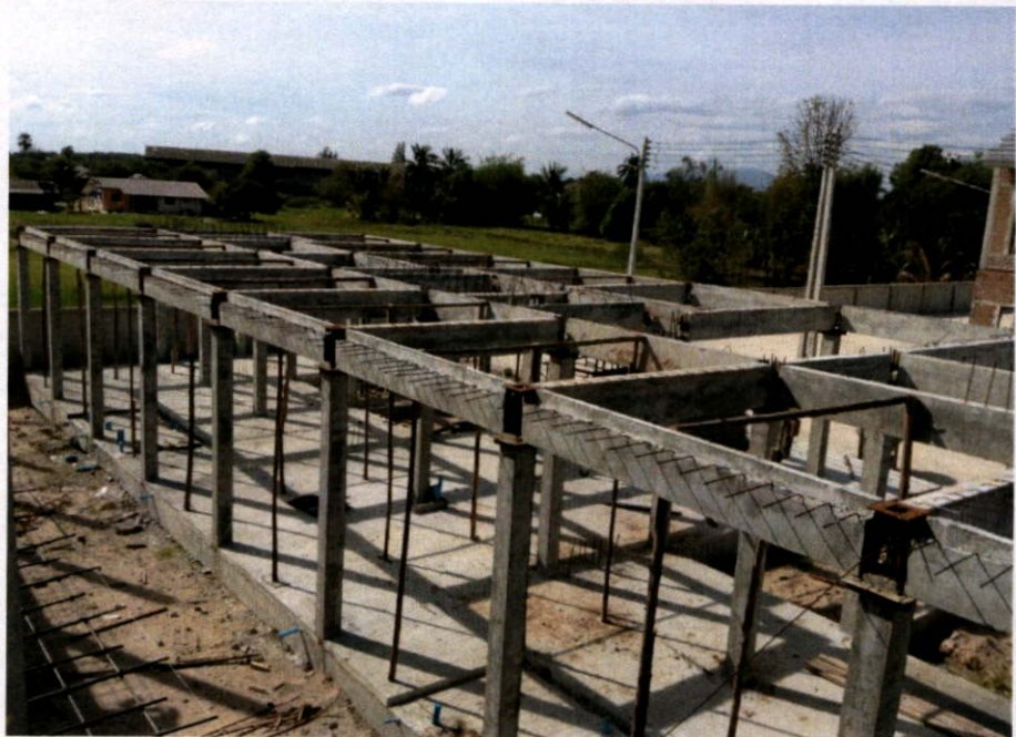
เสร็จสิ้นงานประกอบติดตั้งคานชั้น 2 และเพลาทรงรับหัวเสา วันที่ 28 กันยายน 2556
