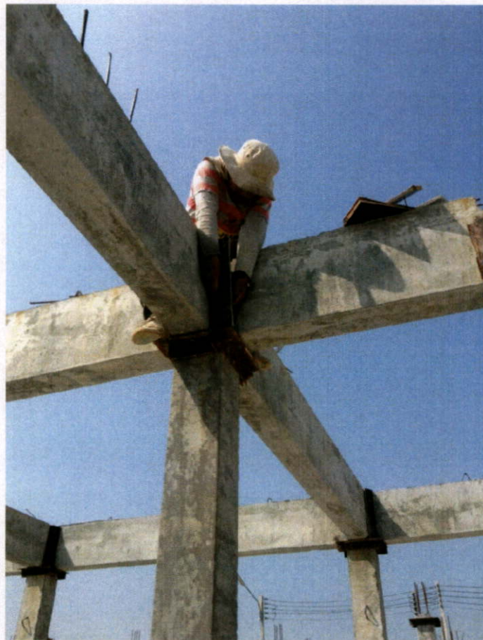
รูปที่ 4.29 การเข้าแบบไม้ ณ จุดรอยต่อระหว่าง เสา-คาน
