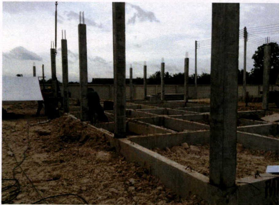
งานติดตั้งชิ้นส่วนสำเร็จรูปเสาชั้น 1 วันที่ 22 สิงหาคม 2556
