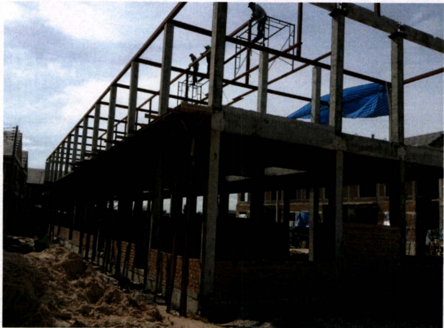
เสร็จสิ้นงานพื้นชั้น 2 และขึ้นงานโครงหลังคา วันที่ 25 ตุลาคม 2556
