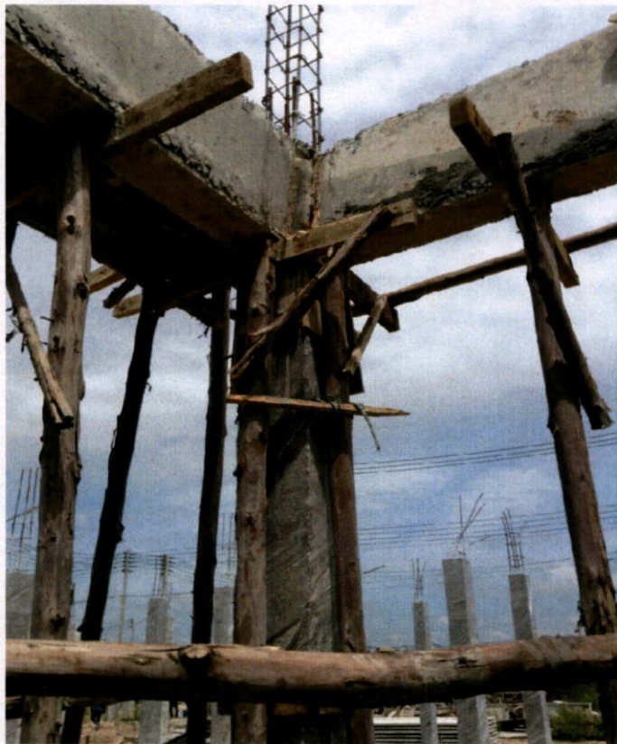
รูปที่ 4.8 การค้ำยันห้องคานชั้น 2
