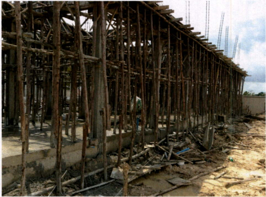
รูปที่ 4.7 การประกอบไม้แบบ และการค้ำยันห้องคานชั้น 2
