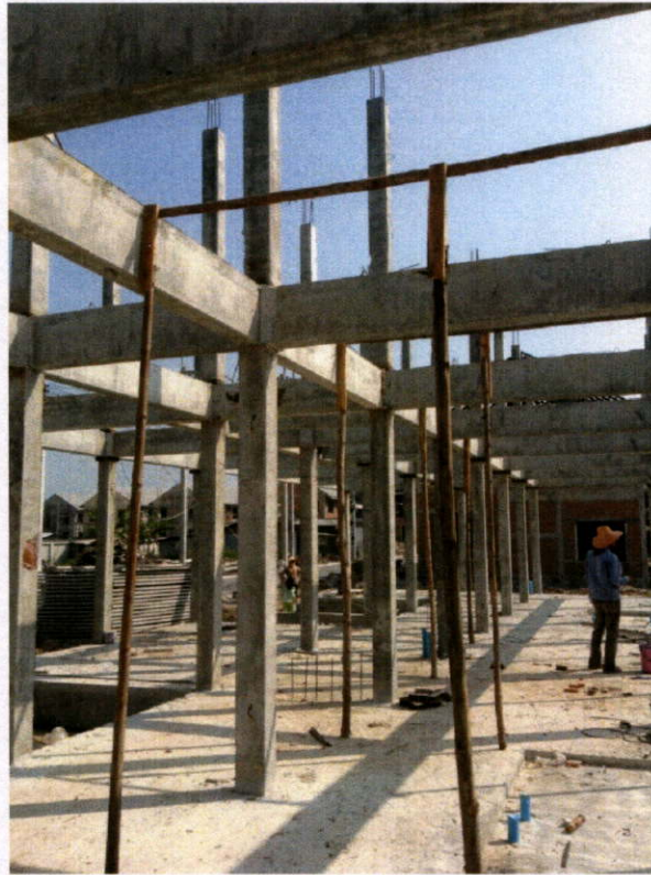
รูปที่ 4.12 การตั้งค้ำยันห้องพื้นชั้น 2
