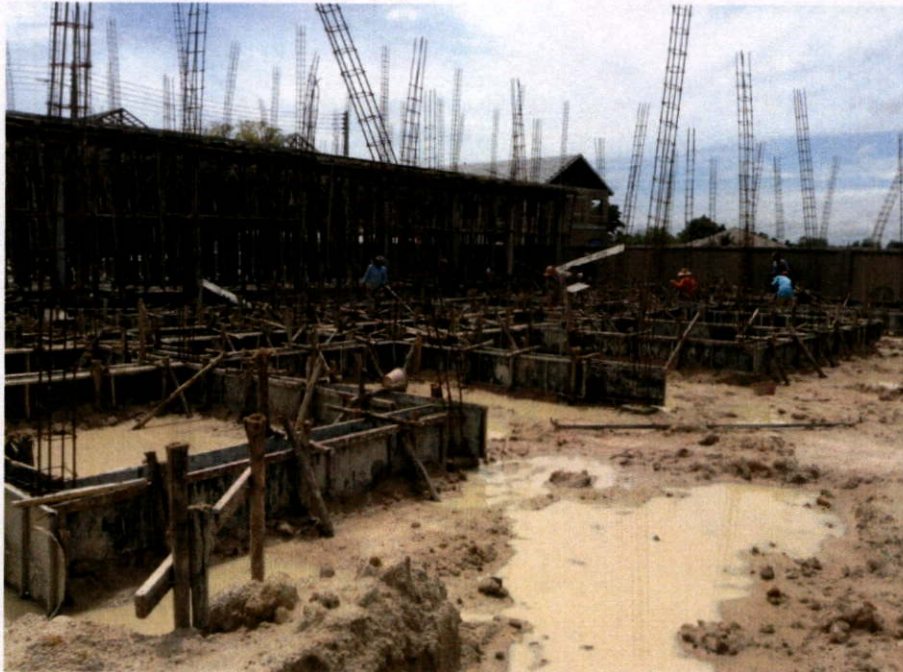
งานคานชั้น 1 วันที่ 22 สิงหาคม 2556
