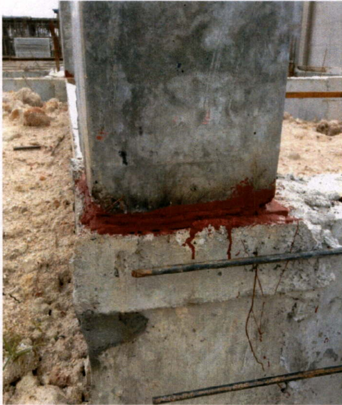
รูปที่ 4.20 เพลทเหล็กระหว่างรอยต่อที่ทาสีกันสนิมแล้ว
