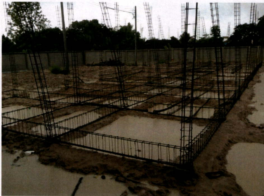
งานคานชั้น 1 วันที่ 5 กันยายน 2556
