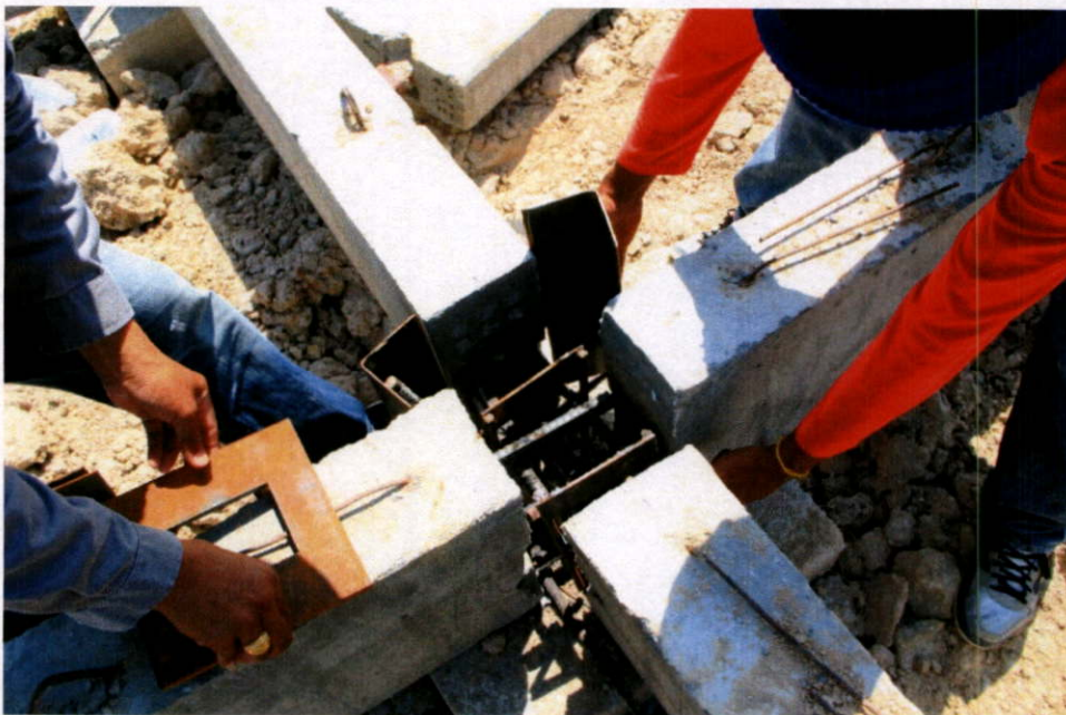
รูปที่ 4.16 การเชื่อมเพลทเหล็กรองรับหัวเสาและการเข้าแบบข้างของรอยต่อ
