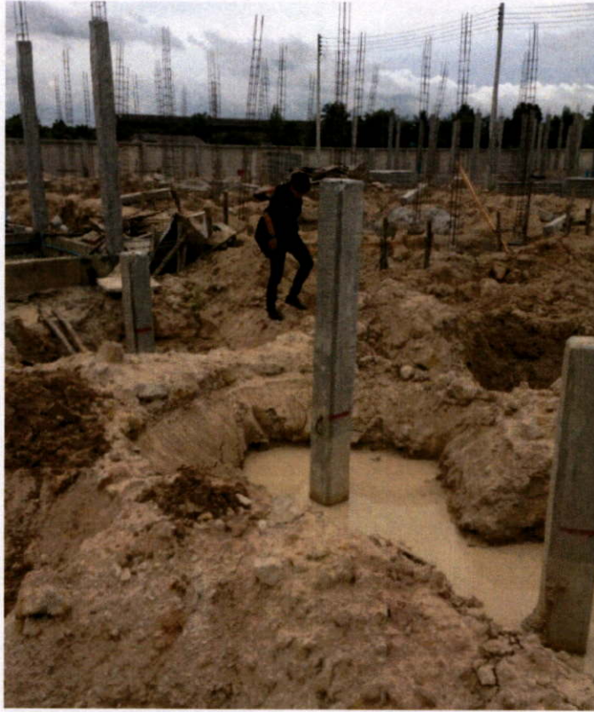
เริ่มงานตัดหัวเสาเข็ม วันที่ 16 สิงหาคม 2556
