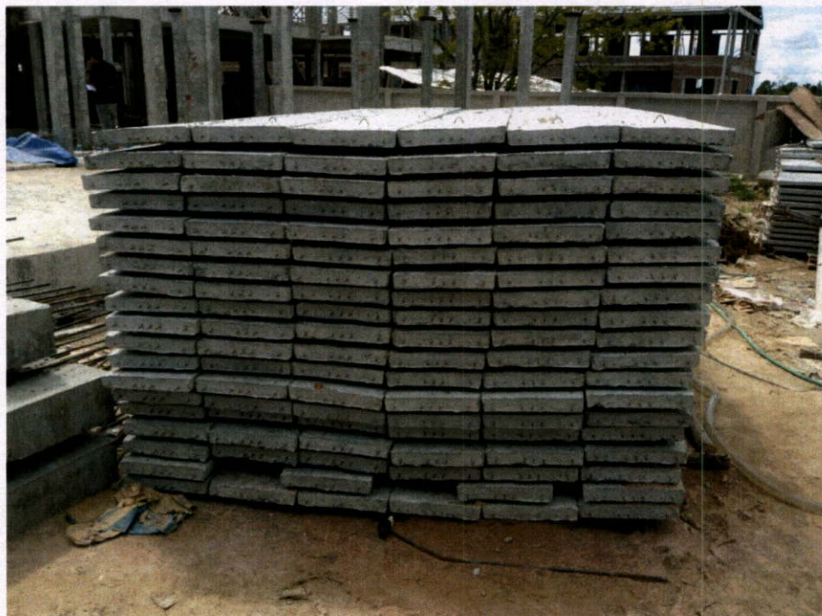
รูป 4.14 การกองเก็บชิ้นส่วนแผ่นพื้นสำเร็จรูป
