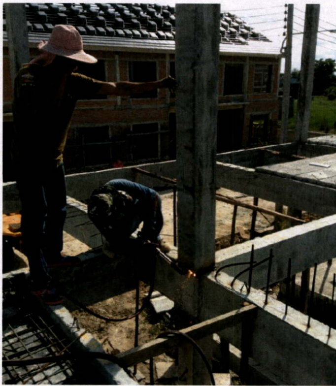
รูปที่ 4.30 การประกอบติดตั้ง และการเชื่อม ชิ้นส่วนเสาสำเร็จรูป ชั้น 2
