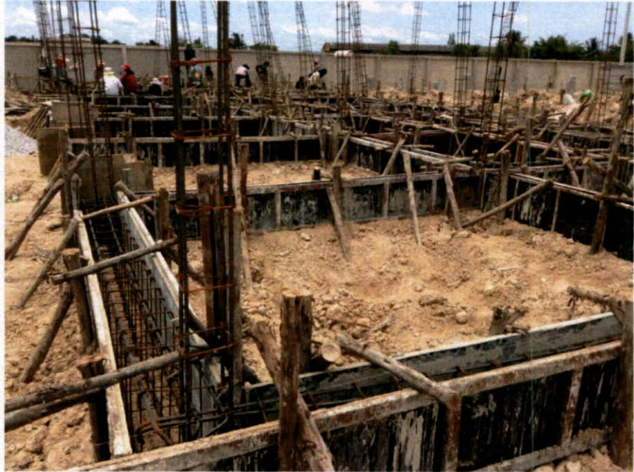
รูปที่ 4.2 การวางเหล็กเสริม การประกอบไม้แบบและการค้ำยันไม้แบบคานชั้น 1
