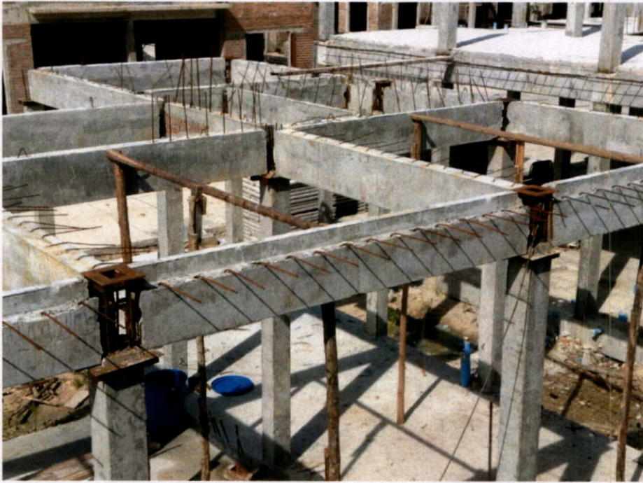
รูปที่ 4.28 การเชื่อมเหล็กฝักในชิ้นส่วนคาน เสาสำเร็จรูป และการติดตั้งเพลาทรงรับหัวเสา
