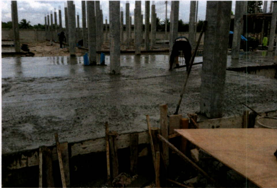
รูปที่ 4.6 การประกอบไม้แบบด้านข้าง และการเทคอนกรีตทับหน้าพื้นชั้น 1
