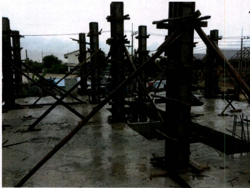
รูปที่ 4.10 การประกอบไม้แบบ และการค้ำยันไม้แบบเสาชั้น 2
