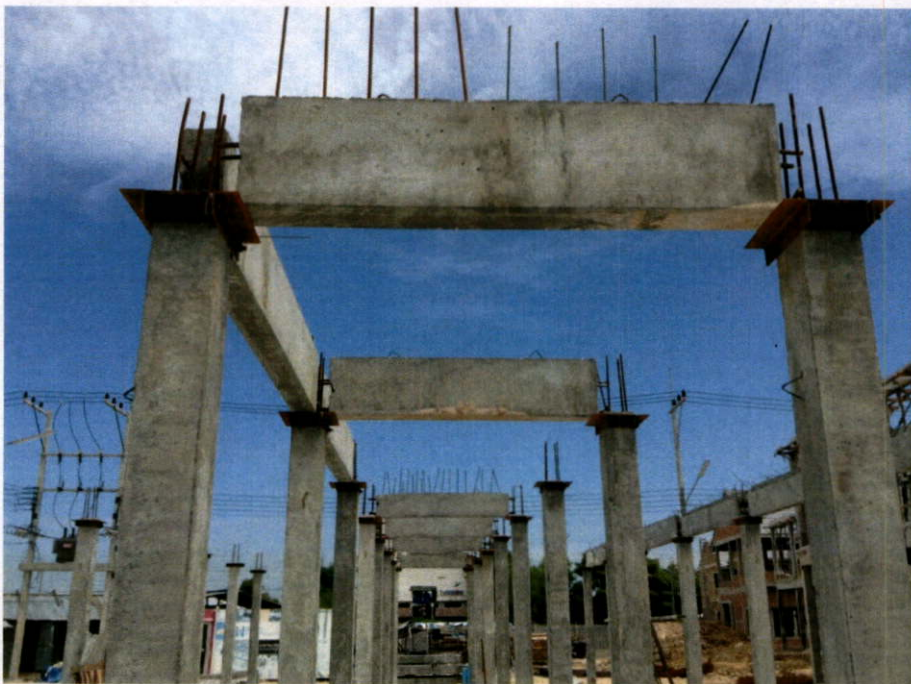
รูปที่ 4.26 เพลตเหล็กรองรับหัวเสา
