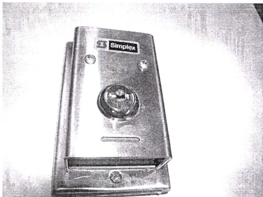
รูปที่ 4.2 อุปกรณ์แจ้งเหตุฉุกเฉินที่ติดตั้ง อาคารผู้โดยสารระหว่างประเทศ อาคาร 1
