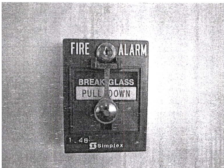
รูปที่ 2.6 อุปกรณ์ Manual Station
