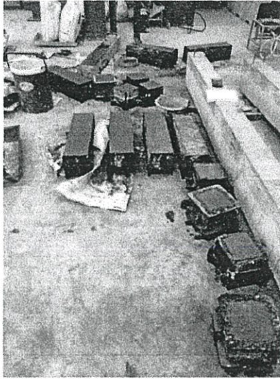
รูปที่ 3.2 เทคอนกรีตลงในแบบหล่อ
