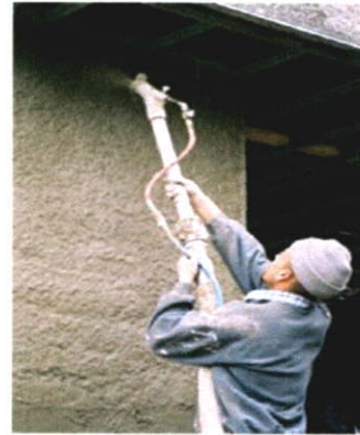
รูปที่ 2.1 แสดงการทำงานคอนกรีตพื้น หรือ Shortcrete
