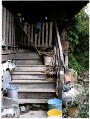
บันไดด้านหลัง
