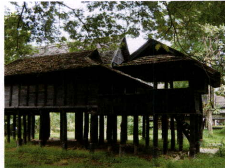
ด้านข้างตัวอาคาร
