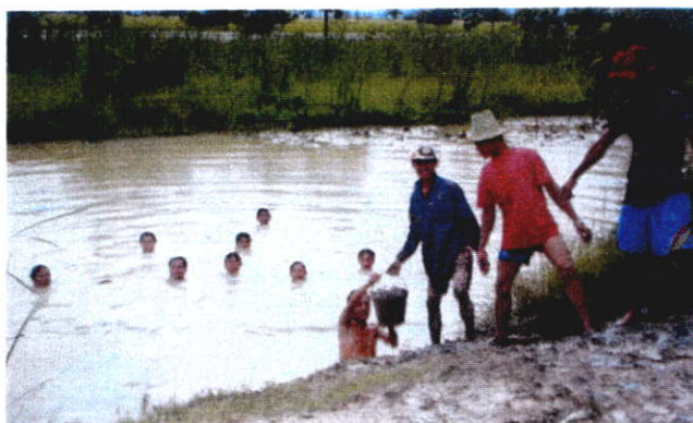
ภาพที่ 2.37 ใช้แรงงานตักดินเลนได้นำในคลองส่งน้ำ
