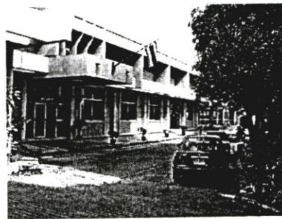
ภาพที่ 4.2 การเข้าถึง อาคารอบรมส่วนอุตสาหกรรมเครื่องเรือนไม้
