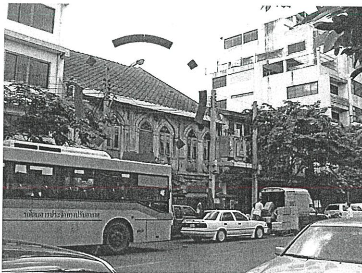
ภาพที่ 4.19 แสดงลักษณะอาคารที่หลังคามุงกระเบื้องว่าว
