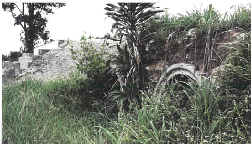
ภาพที่ 4.10 หลุมหลบภัยแบบท่อ
