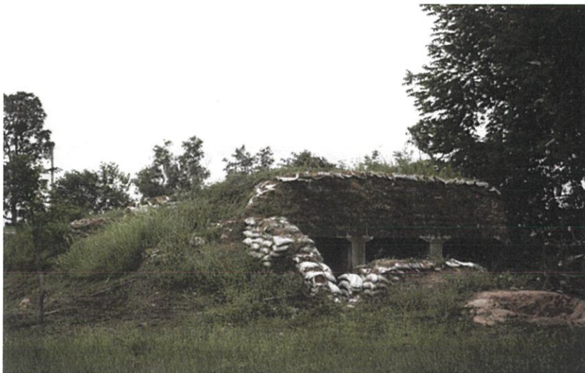
ภาพที่ 4.9 หลุมหลบภัยแบบบล็อกคอนกรีต
