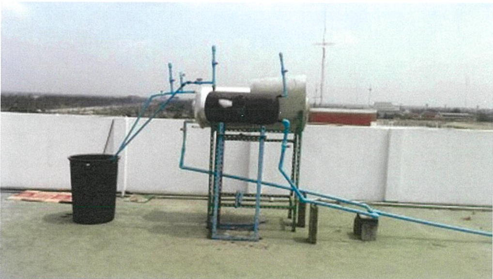
รูปที่ 3.6 แสดงระบบกาลักน้ำที่สร้างได้จริง
