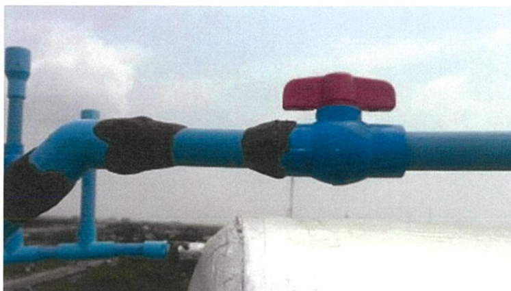
รูปแสดงการอุดรอยรั่วป้องกันอากาศเข้าสู่ระบบ โดยใช้ดินน้ำมัน
