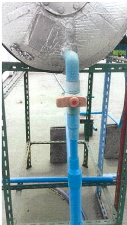
รูปแสดงวาล์วเปิด-ปิดท่อน้ำขาออก
