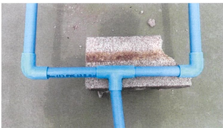
รูปแสดงข้อต่อการรวมของน้ำสองท่อให้ไหลออกท่อเดียวกัน
