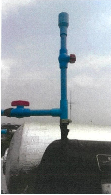
รูปแสดงท่อเติมน้ำเข้าสู่ระบบ
