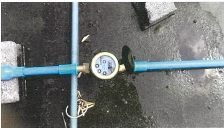
รูปแสดงการวัดปริมาตรของน้ำโดยใช้มิเตอร์น้ำ
