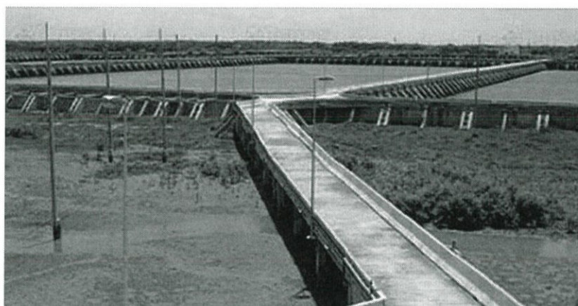
รูปที่ 2.5 บ่อบำบัดน้ำเสียด่านสมุทรปราการ
