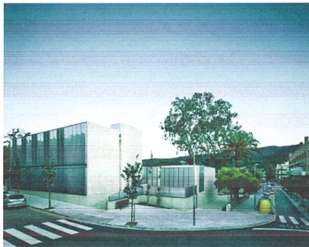
รูปที่ 3.24 แสดงให้เห็นทางเข้าพนักงาน
