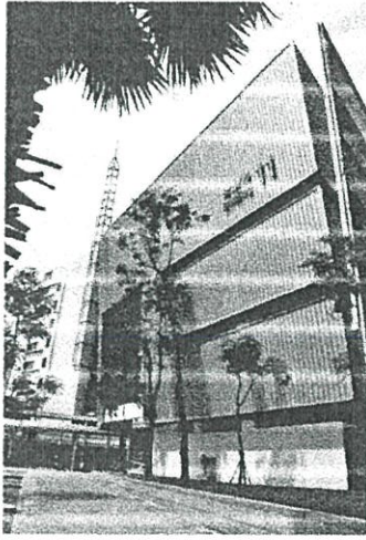
ภาพที่ 8 ภาพด้านหน้าทางเข้า อาคาร11
