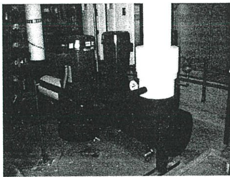
ภาพที่ 2.3 เครื่องทำน้ำเย็นและเครื่องสูบน้ำระบายความร้อน
