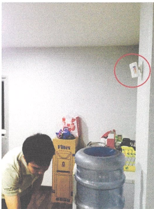
รูปที่ 4.7 เซนเซอร์ตรวจจับความเคลื่อนไหวบริเวณที่ดื่มกาแฟ (Pantry)
