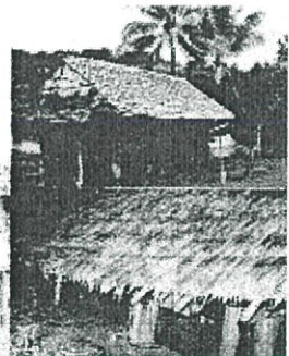
วัสดุผนังหลังคาในท้องถิ่นใช้ใบหวาย ใบตองตึง ไม้ไผ่ ที่เลือกใช้เนื่องจากตามความเหมาะสมของ ภูมิอากาศ
