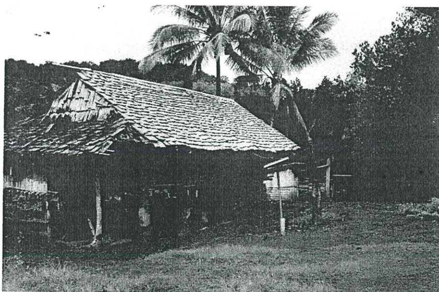
ภาพที่ 7. 24 บ้านชาวปกากะญอที่มุงด้วยหลังคาปีกไม้
