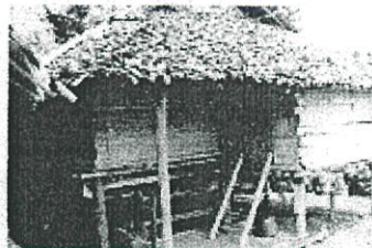
วัสดุผนังหลังคาในท้องถิ่นใช้ใบหวาย ใบตองตึง ไม้ไผ่ ที่เลือกใช้เนื่องจากตามความเหมาะสมของ ภูมิอากาศ
