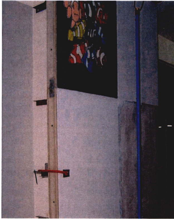
ภาพที่ 4.11 การทดสอบการต้านทานการซึมผ่านของน้ำฝนของชุดผนัง โดยใช้หมั้นอุดรอยต่อ
