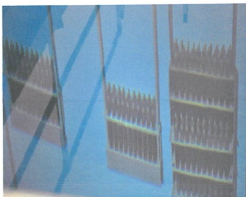
รูปที่ 2.38 ที่เก็บแท่งเชื้อเพลิงภายในสระน้ำเครื่องปฏิกรณ์
