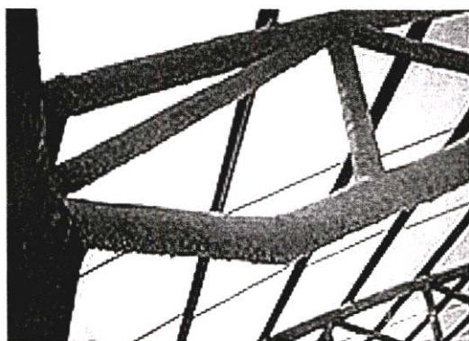
ภาพที่ 4.48 โครงสร้างเหล็กพ่นฉนวนกันไฟ
