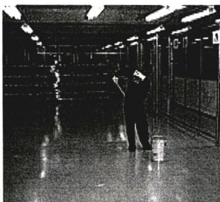
ภาพที่ 4.80 พื้นภายในอาคารเคลือบด้วย Epoxy Polymers
