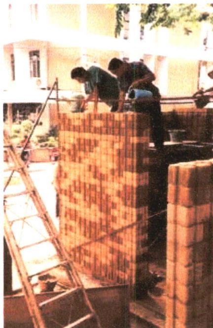
ภาพที่ 2.14 การก่อบล็อกสลับแนวซ้อนทับกัน
