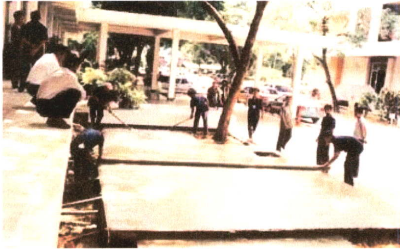
ภาพที่ 2.12 การเทคอนกรีตทำฐานและพื้น
