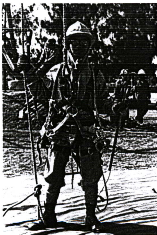
รูปที่ 3.5 Line Man Harness ที่ใช้กับงาน 500 kV. Bare Hand ของ กฟผ.
