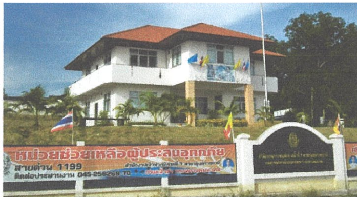
รูปที่ 6.4-6 แสดงสภาพอาคารข้างเคียงของที่ตั้ง โครงการฝั่งทิศตะวันตก (สำนักงานการขนส่งทางน้ำที่ 7 จ.อุบลราชธานี)
