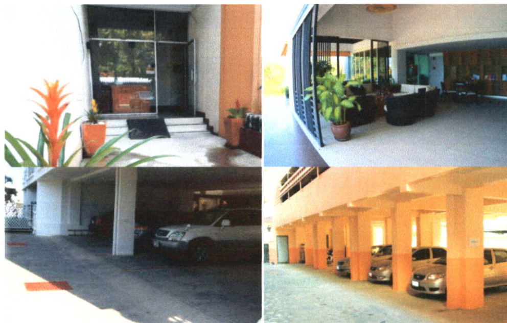
ภาพที่ 311 ตัวอย่างคอนโดมิเนียมก่อนดำเนินโครงการ (คอนโดมิเนียมในกลุ่มที่ศึกษา)
