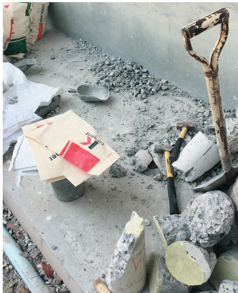
รูปที่ ค.2 การบดเศษคอนกรีต
