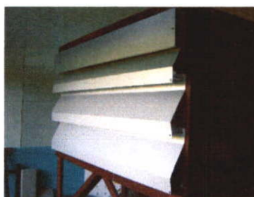
ภาพที่ 3.1 บล็อกช่องลมชนิดลิ้นคู่ และเกล็ดกระเบื้อง
