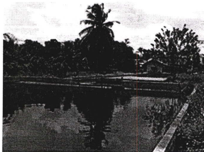
รูปที่ 4.16 บ่อพักน้ำเสีย(บ่อที่ 2) ในชุมชนพื้นนกรรมเกล้า โซน 8
