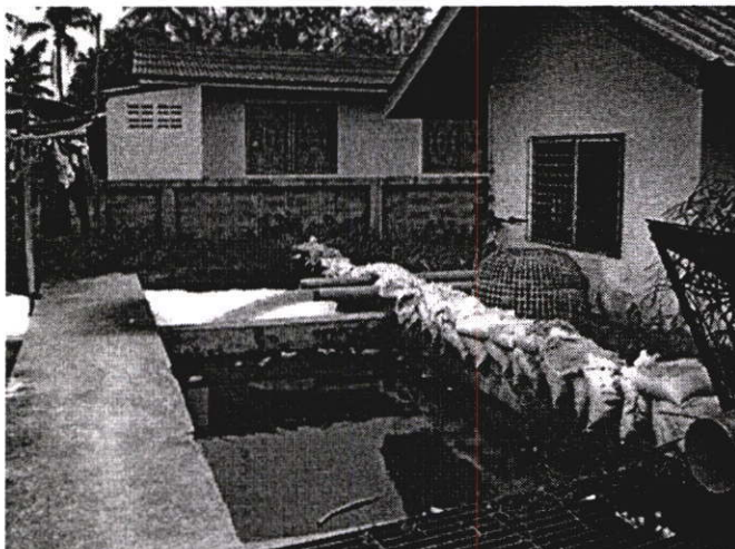
รูปที่ 4.21 อาคารสูบน้ำเข้าสู่บ่อพักน้ำเสียในชุมชนพื้นนคร่วมเกล้า โขน 10
