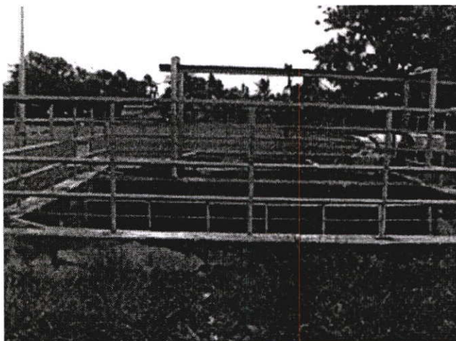
รูปที่ 4.5 บ่อรับน้ำเสียเข้าสู่โรงปรับปรุงคุณภาพน้ำร่วมเกล้า
