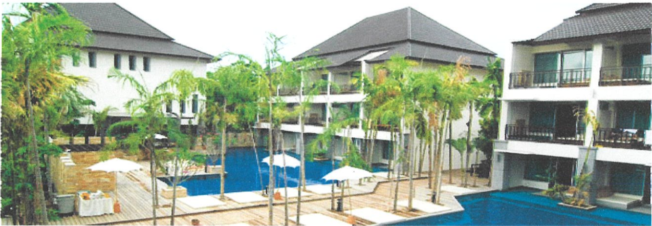
รูปที่ 5 แสดงอาคารที่พักและอาคารต้อนรับ
