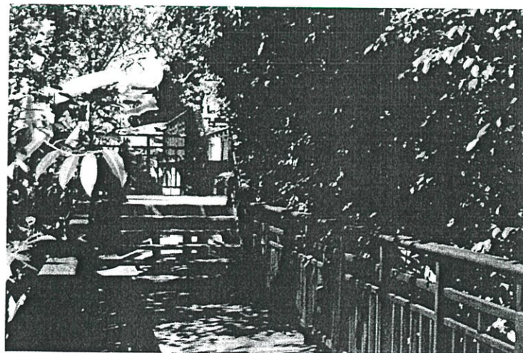
รูปที่ 3.9 ภาพแสดงสะพานเชื่อมที่มาจากจุดต้อนรับหน้าโครงการ
