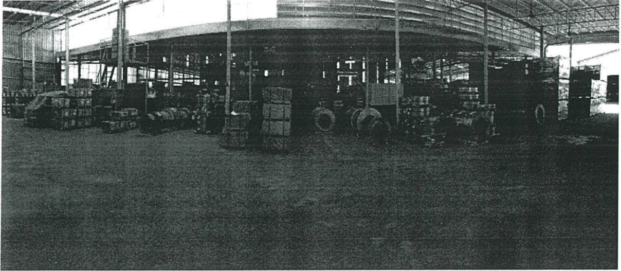
รูปที่ 4.26 หลังดำเนินการปรับปรุง
