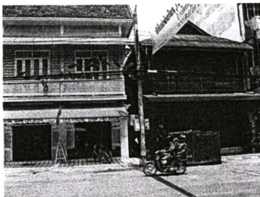
รูปที่ 5.31 แสดงสภาพอาคารร้านเกสร
