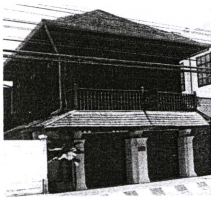
รูปที่ 4.29 อาคารเลขที่ 276-8 (ร้าน Living Space) ส่วนตกแต่งอาคารคือจะมีราวระเบียงลูกกรงไม้ที่ชั้นสองและเสารูปนที่ทำเพิ่มเติมในภายหลังที่บริเวณหน้าร้าน ถ่ายภาพโดย : ผู้วิจัย พ.ศ. 2548
