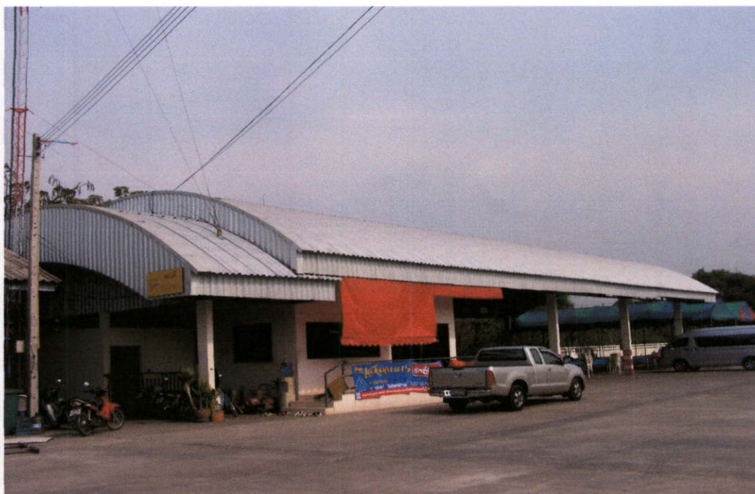
ภาพที่ 4.6 ด้านหน้าอาคารโรงจอดรถดับเพลิง
