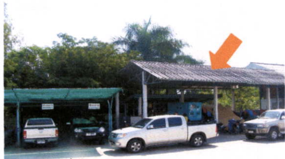
พื้นที่โรงรถที่จะทำการก่อสร้างต่อเติมเป็นสำนัก ทะเบียนเพราะพื้นที่เดิมมีพื้นที่บริการไม่เพียงพอ
