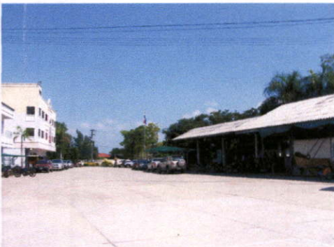
อาคารศูนย์เด็กเล็กที่กำลังวางผังดำเนินการ
