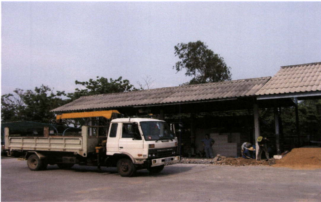
ภาพที่ 4.4 ด้านหน้าอาคารที่กำลังก่อสร้าง
