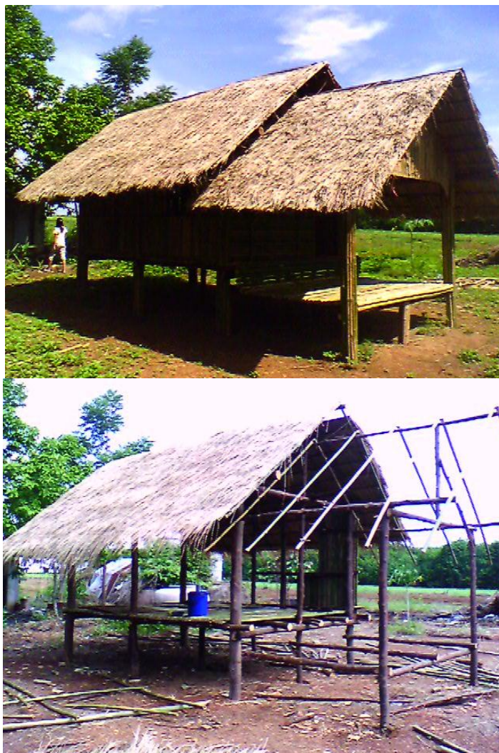
ภาพที่ 2.11 การก่อสร้างบ้านกระต๊อบ
