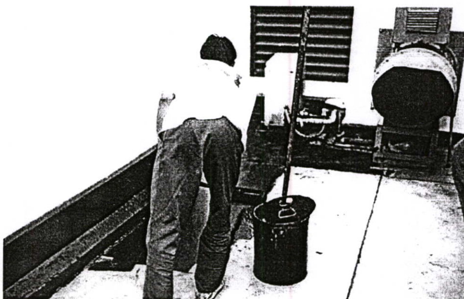
รูปที่ 2.36 แสดงวิธีการทาน้ำยารองพื้นก่อนจะวางแผ่นยางสำเร็จบนชั้นดาดฟ้าของอาคารท่าอากาศยานดอนเมือง
