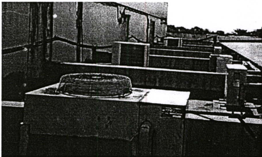
รูปที่ 2.26 แสดงการใช้พื้นที่บนคานฝ้าของอาคารท่าอากาศยานหาดใหญ่
