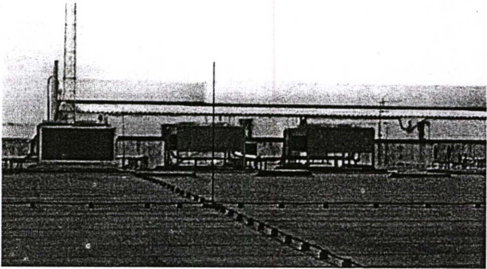
รูปที่ 2.32 แสดงชั้นดาดฟ้าอาคารท่าอากาศยานหาดใหญ่ หลังจากการซ่อมแซมเสร็จแล้ว
