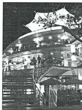
ภาพที่ 5 ส่วนทางเดินบันไดที่เชื่อมกับทุกชั้น
