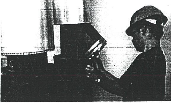
รูปที่ 3.47 ถอด STRAINER ออกทำความสะอาด
