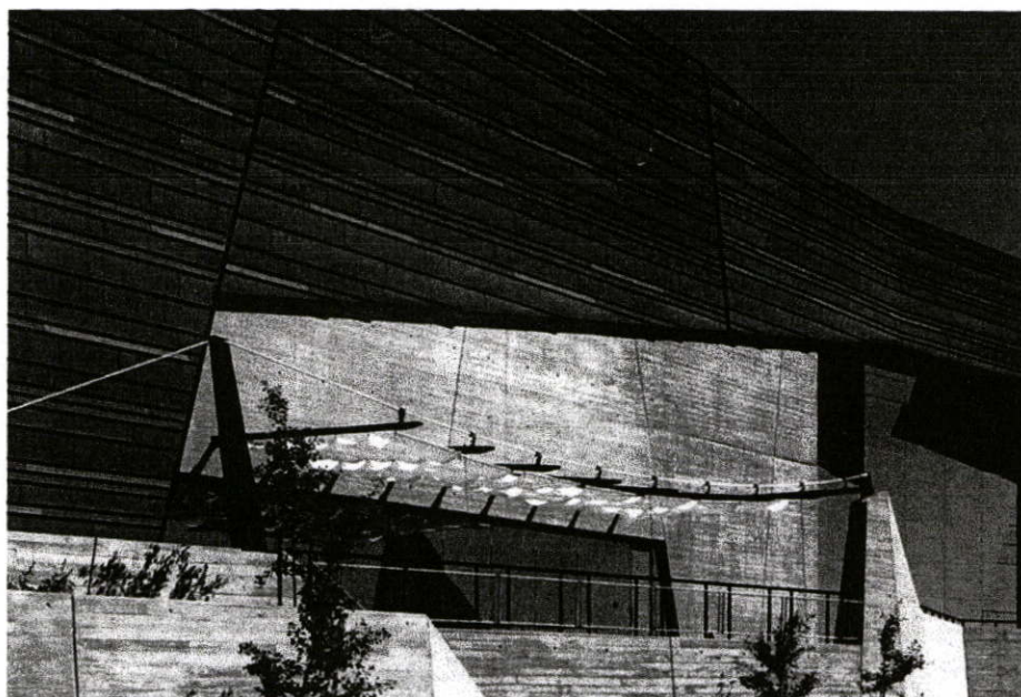
รูปที่ 3.56 แสดงบริเวณที่ใช้คอนกรีต
