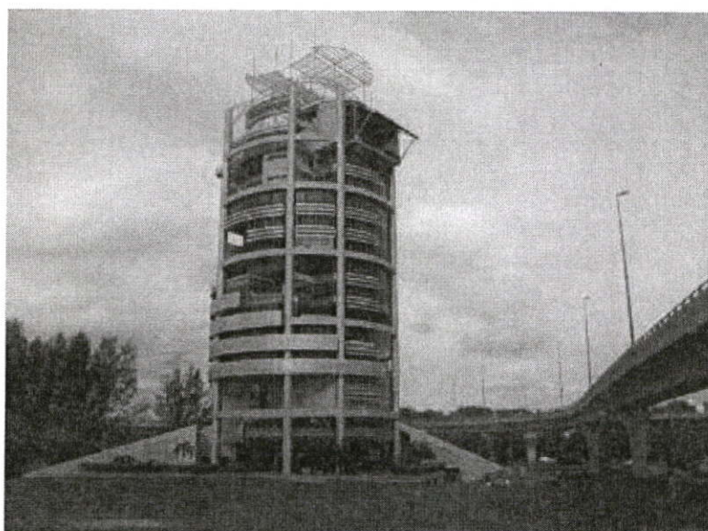
ภาพที่ 3.9 แสดงอาคาร Menara Mesiniaga
